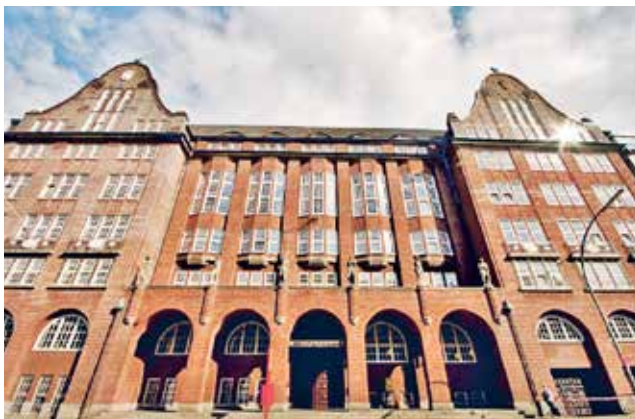
Die Handwerkskammer Hamburg am Holstenwall, erbaut von 1912 bis 1915
